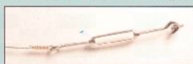
Poner tensor y anclar al extremo opuesto del alambre
